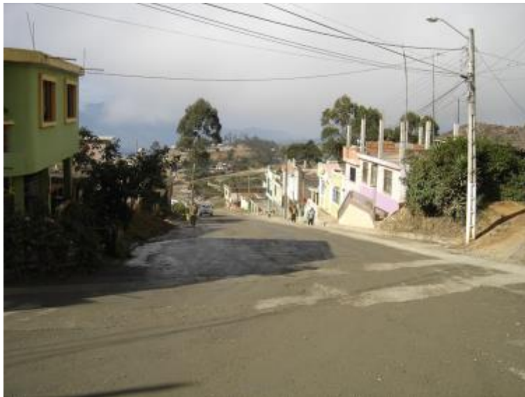
Imagen 1.1: Sector de inicio del Tramo Céllica-Cruzpamba Km 00+000 (Inicio de la vía)
