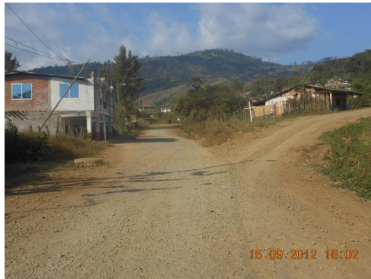
Imagen 1.3: Sector de inicio del Tramo Cruzpamba-Y de El Muerto. Km 00+000.
