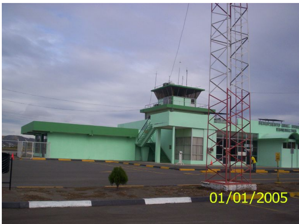
Vista del Edificio Terminal Arpto. Gral. Rivadeneira. Esmeraldas y Torre de Control. Fuente: DGAC
