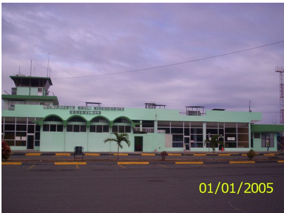
Vista del Edificio Terminal Arpto. Gral. Rivadeneira. Esmeraldas. Lado Este. Fuente: DGAC
