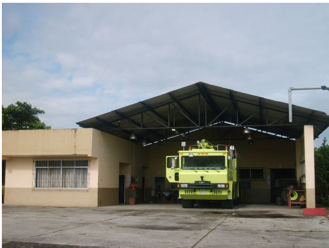
Vista del Edificio del Servicio de Salvamento y Extinción de Incendios – Hangar SCI Fuente: DGAC
