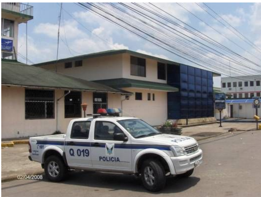
Vista del Edificio Terminal desde el lado tierra
