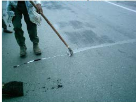
Distribución del asfalto.
