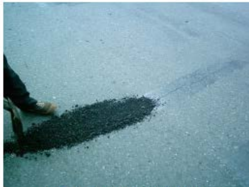
Colocación de la mezcla asfáltica.
