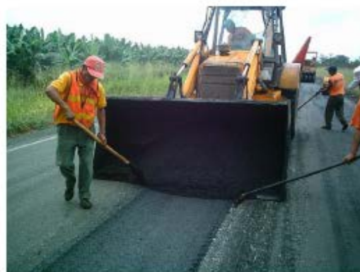
Colocación de la mezcla.
