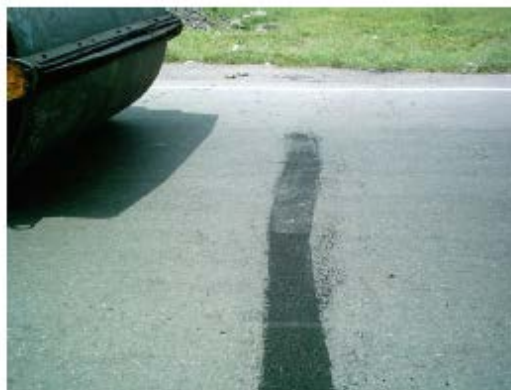
Rodillado de la mezcla extendida.
