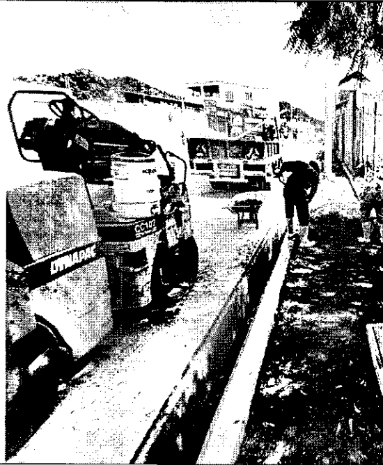
Foto 7: Calle García Moreno, ejecución cunetas poca presencia de obreros, Abcisa 5+200
