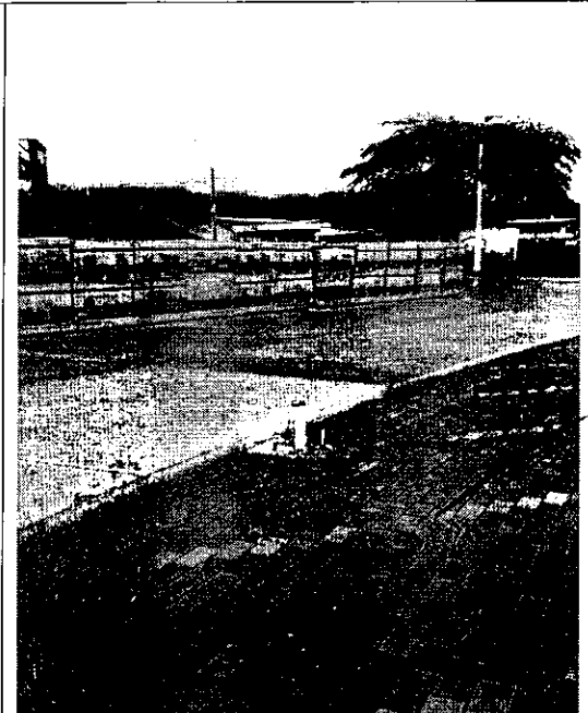
Foto 6: Calle García Moreno, último tramo hormigonado ejecución de cunetas, Abcisa 5+200
